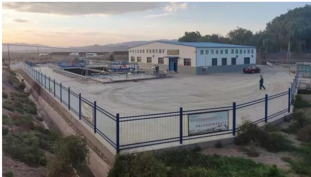
照片 1-33 污水处理站
